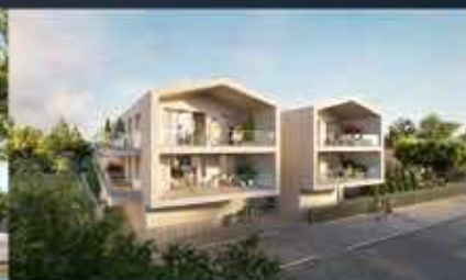
LES BARNS EN TRAVAUX
