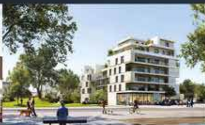
LES PROMENADES D'OLÈNE EN TRAVAUX
