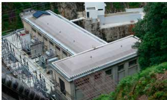
Le barrage de Sarrans
