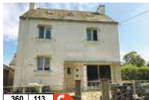
360 113 G kW/m² an kgCO2/m² an PONT DE BUIS LES QUIMERCH 94 680 €
