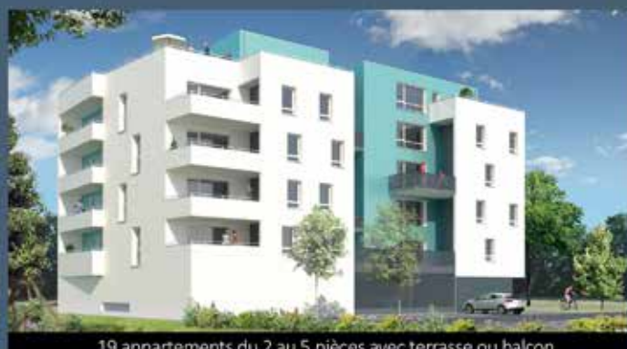
19 appartements du 2 au 5 pièces avec terrasse ou balcon
